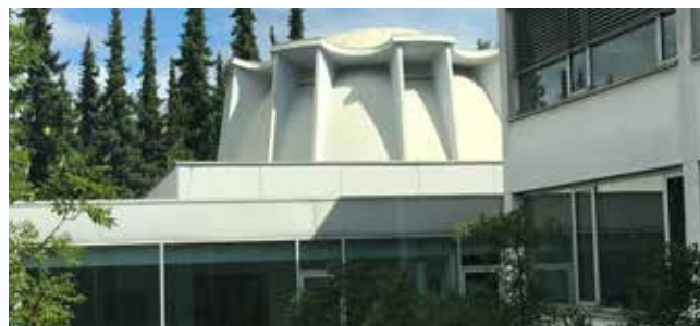
Die 1970 eingeweihte Synagoge bildet bis heute das architektonische Zentrum des Ensembles „Shalom Europa“
