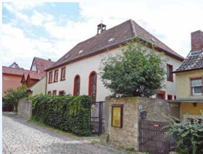
Die ehemalige Synagoge von Sommerhausen hat eine reiche und wechselvolle Geschichte
